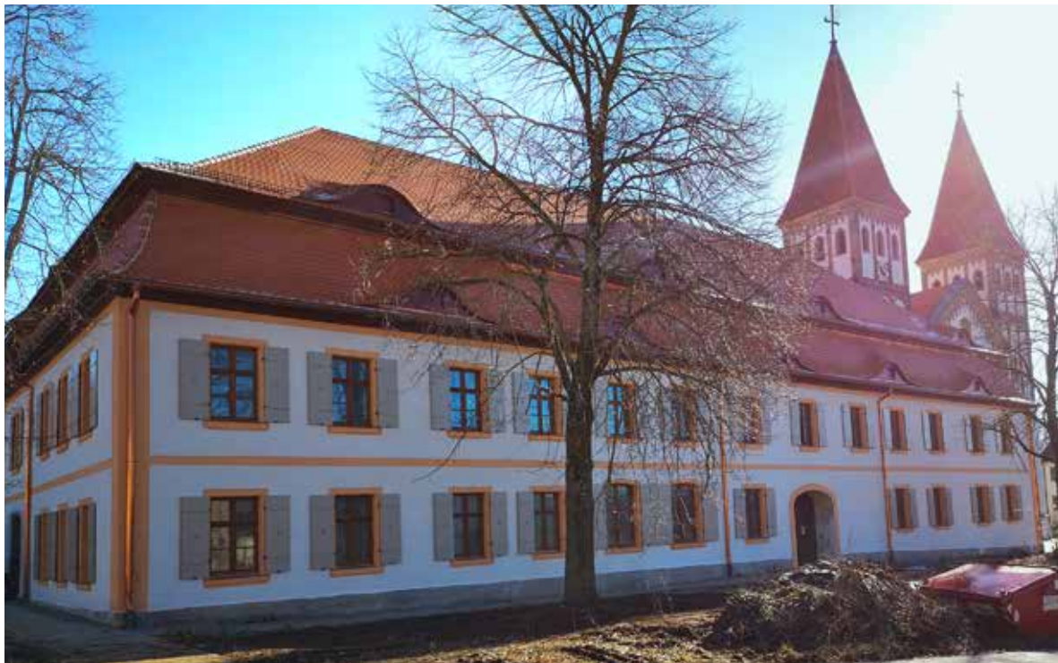
Kloster Heidenheim: Der sanierte und umgebaute Westflügel des Klosters.
